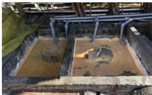
ブラウングリース (BG) 油水分離槽や原水槽に浮上し溜まった油泥
